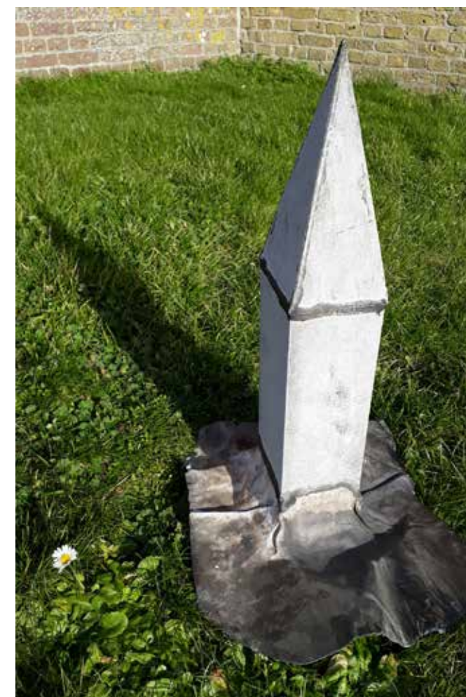
Een voorbeeld van een piron van zink op een afdichtende loodslab.
