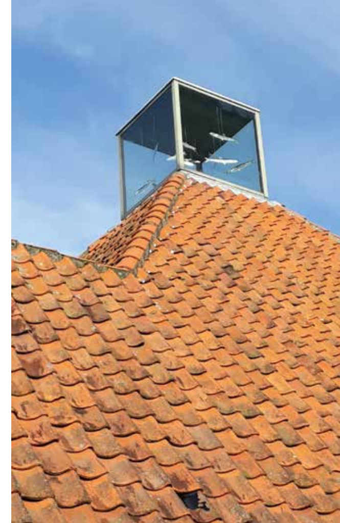
De piron van glas fungeert als vierkante lichtkoepel op het als stolp gebouwde dorpshuis te Kolhorn.
