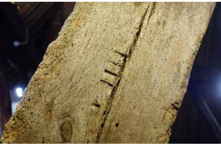
Een telmerk (III) op het vierkant van museumboerderij Vreeburg in Schagen. Deze boerderij is in de eerste helft van de 17e eeuw gebouwd.
