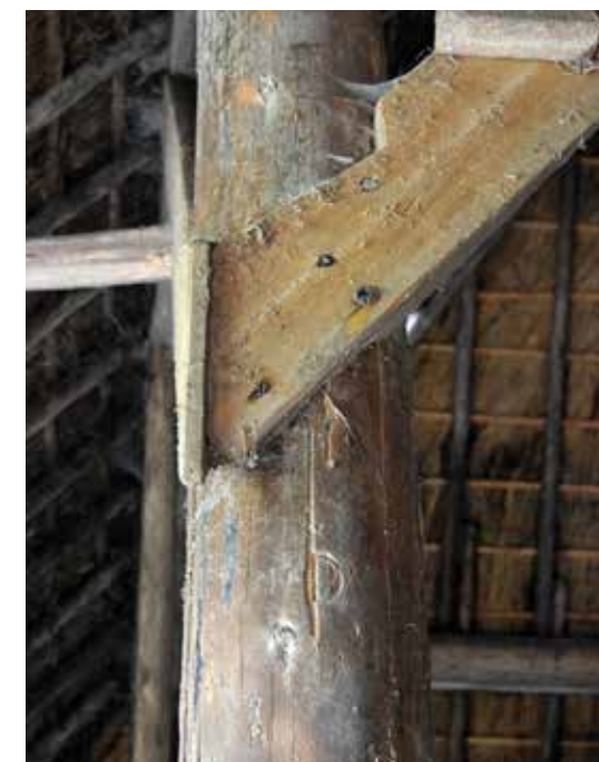
Een vierkantstijl van een stomp in Spierdijk uit 1900 met een telmerk: de letter D, aangebracht onder de zwing (schuine balk).
