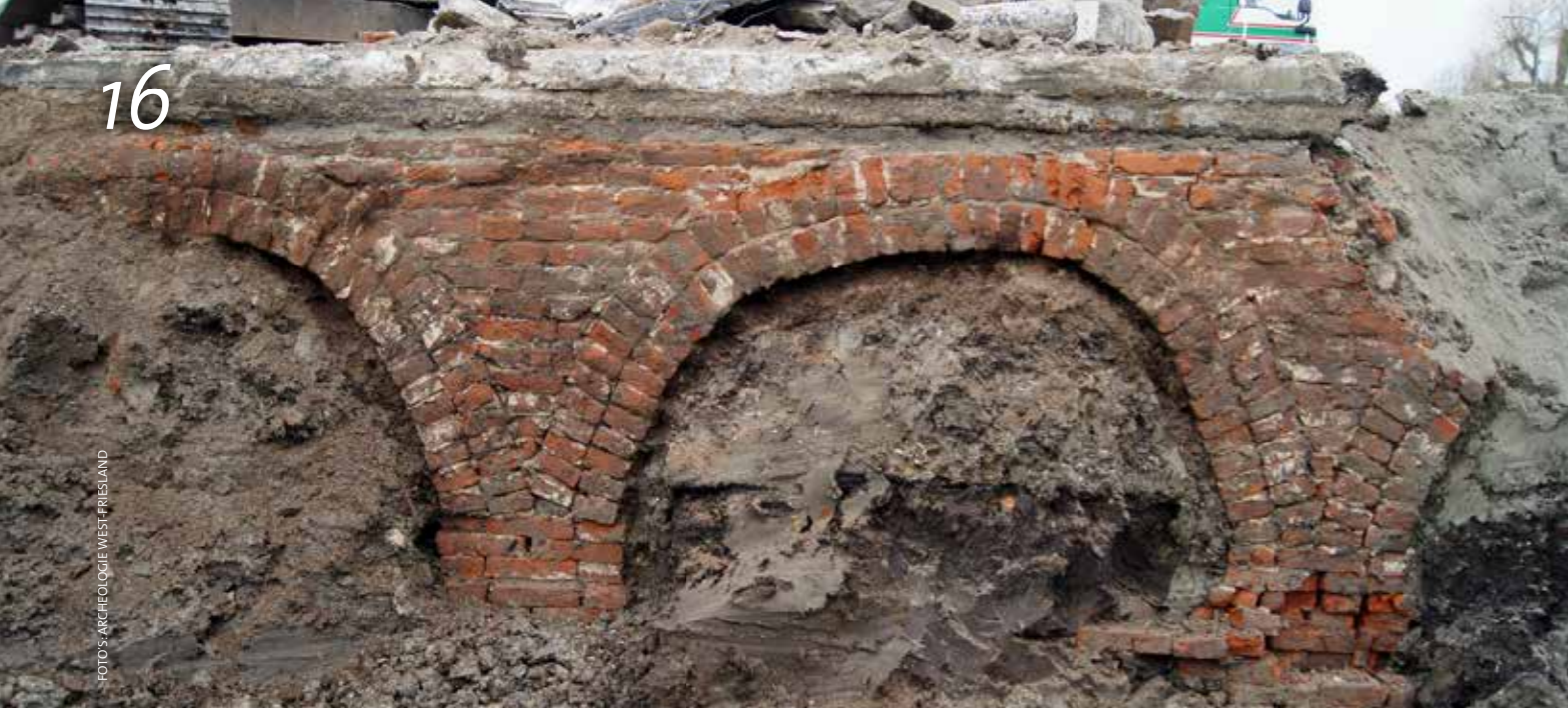
Gedeelte van de spaarboogfundering van een verbrande boerderij in Berkhout (gebouwd 1877)
