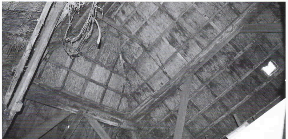
Het interieur toont een vierkantsconstructie.
