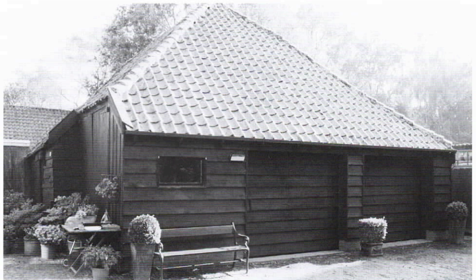
De stierenstolpschuur. Drie houten gepotdekselde gevels en een halfsteens achtergevel.
