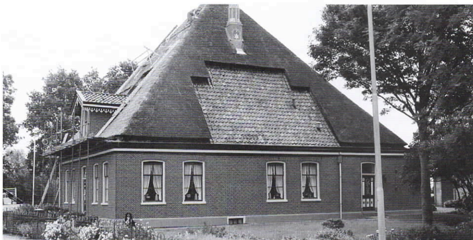
Streekweg 30-32 in Hoogkarspel tijdens dakwerkzaamheden in 2007.
