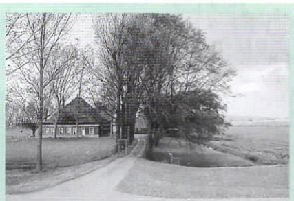
De N242 (Alkmaar/Omval-Heerhugowaard) wordt grootscheeps aangepast, twee stolpen zijn al gesloopt. De gehele hoek met de Huidgendijk (foto) ligt binnenkort onder het asfalt. Er is een plan om de zuidelijker gelegen stolp te verplaatsen.
