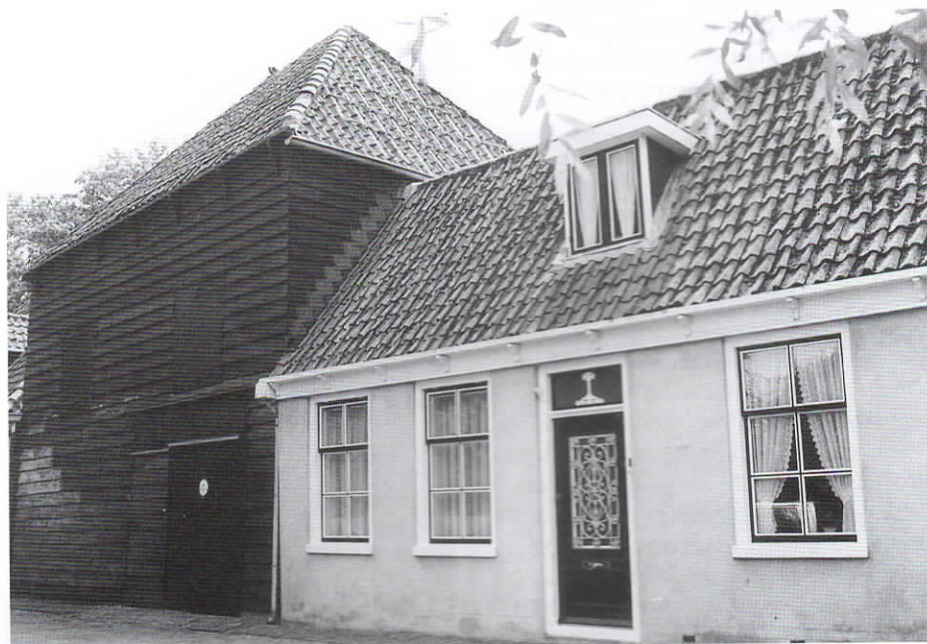
Monnickendam, Roozendaal 10. Stadsboerderij met (nog) originele verhoudingen.
