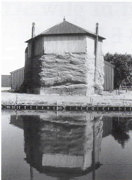
Aan het Noordhollands kanaal bij Purmerland, augustus 2003. Hooi ligt opgeslagen in een zes-kante vijzelberg met drie roeden. Ter bescherming van het hooi zijn onder en boven golfplaten aangebracht.
