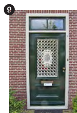
Opperdoes – Gouw 7. Gave stolp met dakspiegel en ronde schoorsteen.
