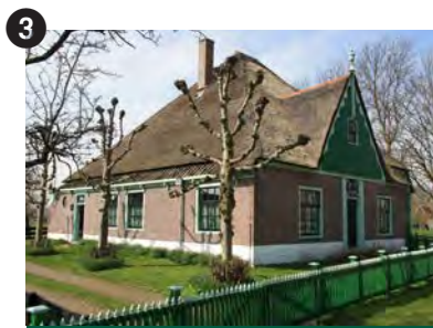
Benningbroek – Dr. de Vriesstraat 12. 17e-eeuwse stolp met een houten topgevel uit 1862 en een rouw- en trouwdeur met bovenlicht.
