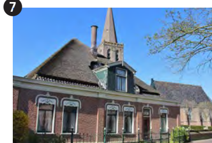
Twisk – dorpsweg 118. De ronde schoorsteen dateert van 1630. En uit 1885 komen de raamversieringen.
