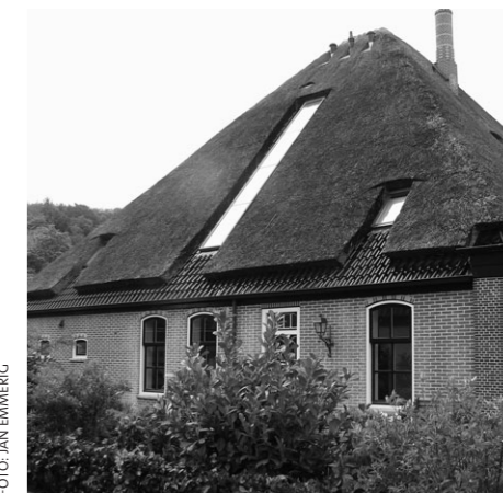
Verticaal dakraam (glasstrook), hier in rieten dak.
