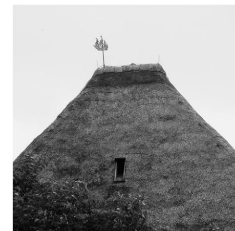
Het gesloten dak met kistgat van agrarisch stolp.
