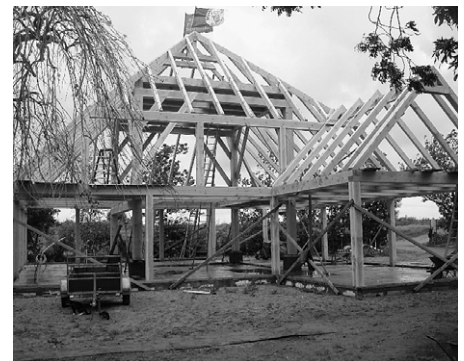
Driehuizen. Nieuwbouw stolpschuur.
