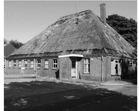
Avenhorn. Sloop nabij.
