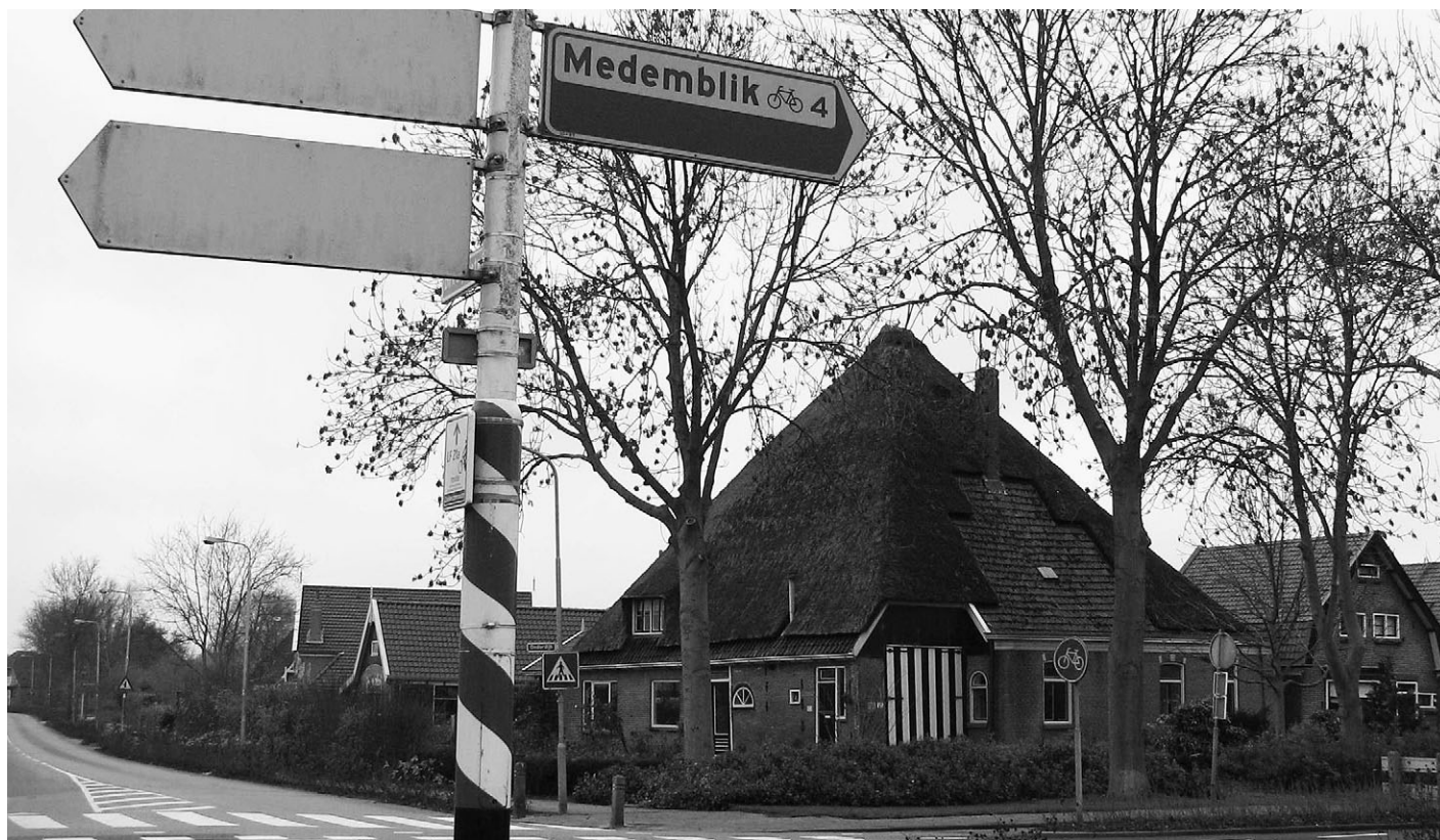
Onderdijk. Sloopvergunning verleend, op basis van twijfelachtige gegevens over de bouwkundige staat.
