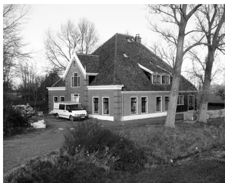
Schoorlдам. Herbouw na brand.
