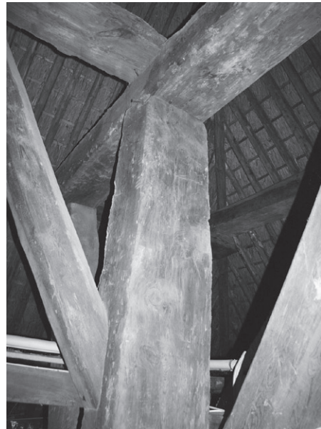
De zware vierkantsconstructie van het Polderhuis.
