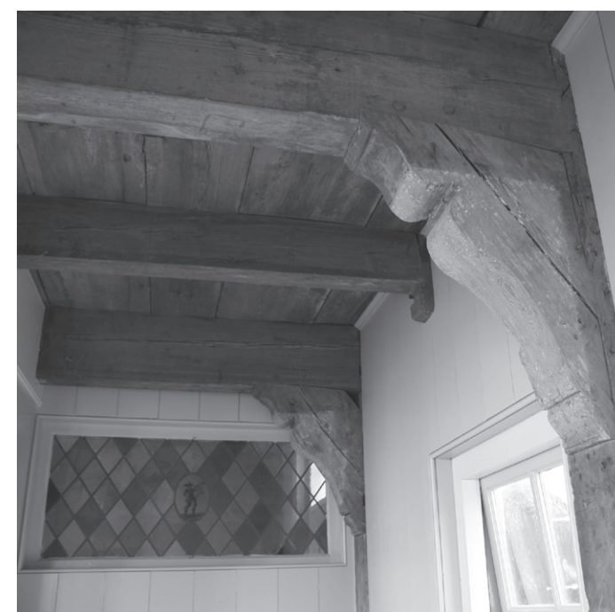
Na de restauratie zijn de korbelen weer in het zicht.
