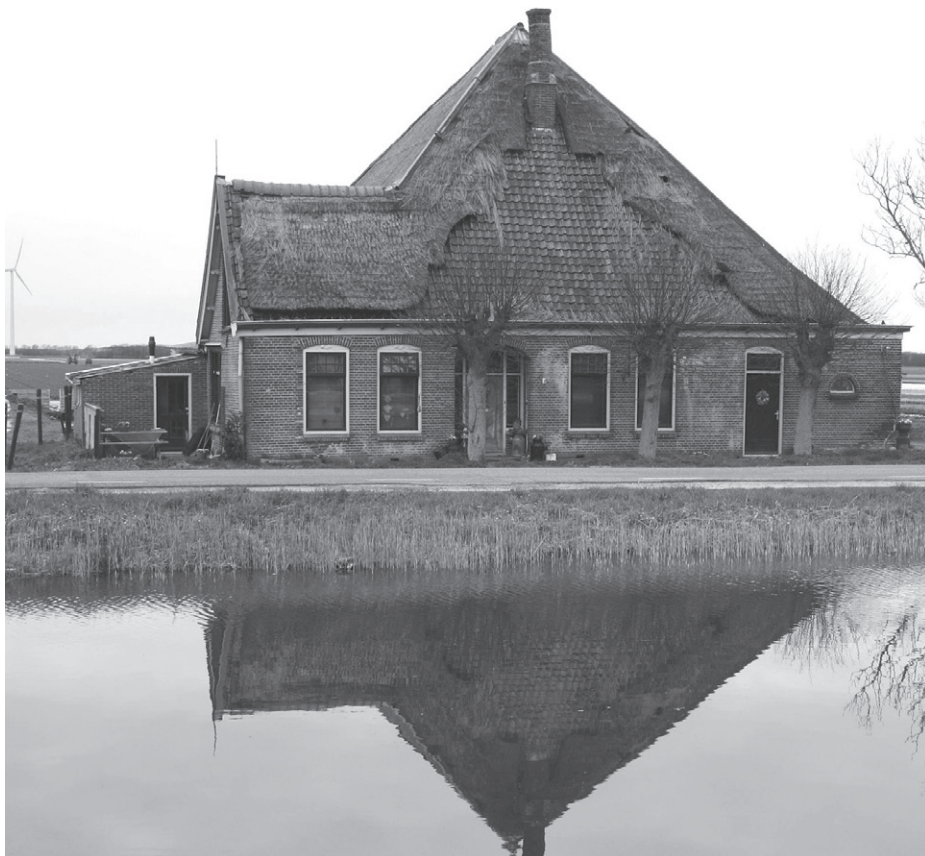
Alle hens aan dak. Herstel is mogelijk met een laagrentende lening. Zie artikel in deze Nieuwsbrief.
