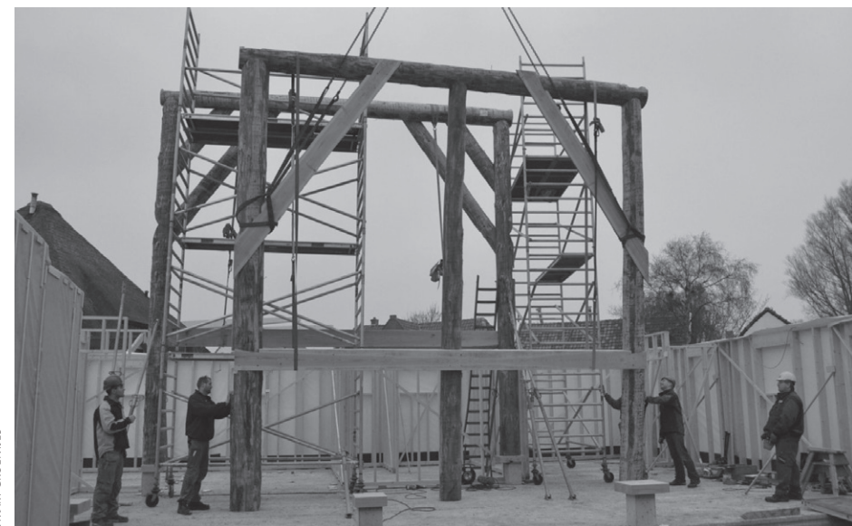
In Schoorl dam een spectaculair transport van vierkantsconstructie (hoog 7 meter) waarna de restauratie van een historische stolpschuur een aanvang neemt. Verdere info en beeld zie: petervlam.com
