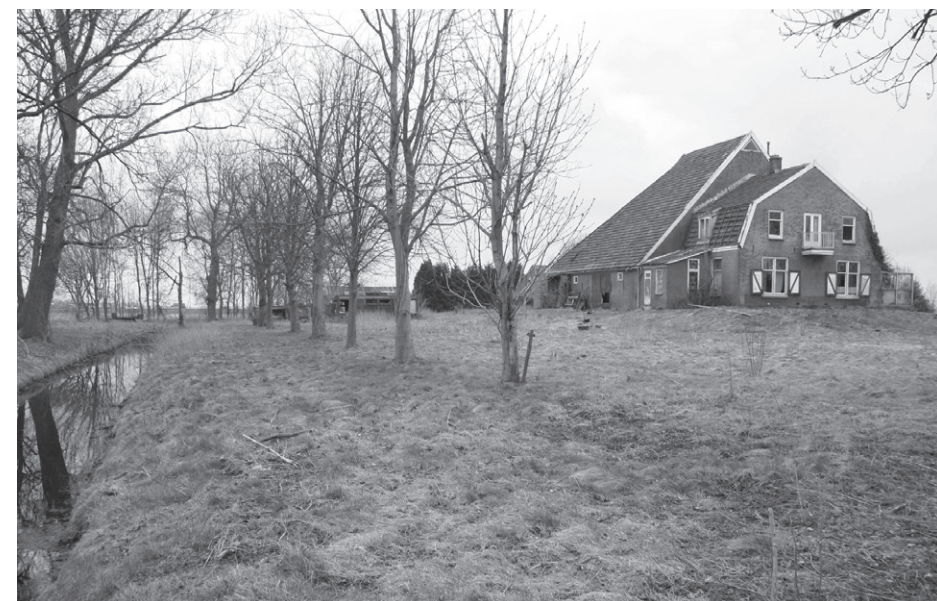
Alkmaar heeft stolpen op de gemeentelijke lijst toegevoegd. Maar de laatste jaren is het stolpenbestand uitgedund door sloop voor wegen en bedrijventerrein. 'Boomlust' bij Oudorp staat op de nominatie te worden gesloopt.
