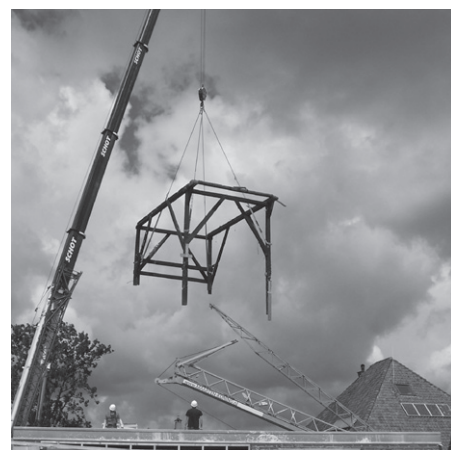
Vliegende vierkantsconstructie in Assendelft.
