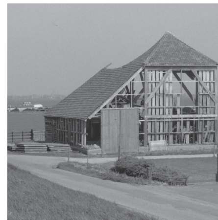
De afbraak is begonnen, 2007 (foto achterzijde).
