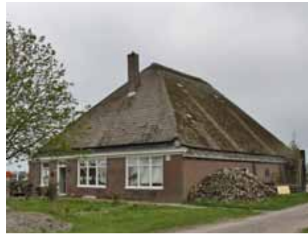
Voorgevel en rechter zijgevel oude stolp.
