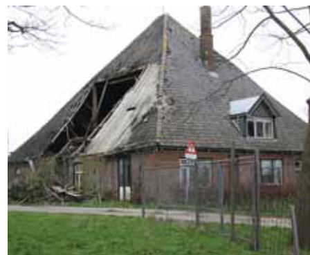
De Hout. Stolp wordt gesloopt.
