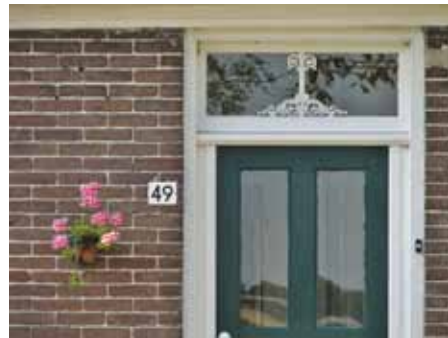
Voordeur met bovenlicht oude stolp.
