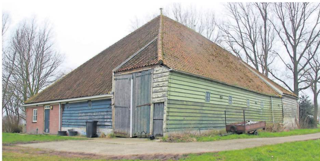
Boerderij Schouwzicht in de Purmer.
