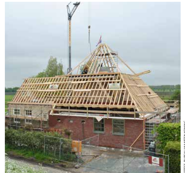
De herbouw is in volle gang.
