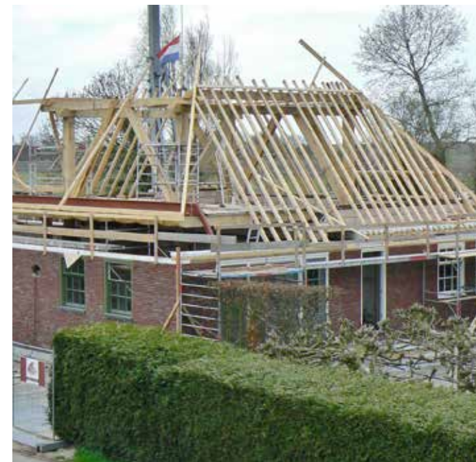
De daksparren worden aangebracht.
