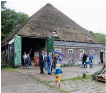
De achtergevel met dorsdeuren.
