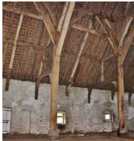
Dekbalkenconstructie en kap van de abdijsschuur.
