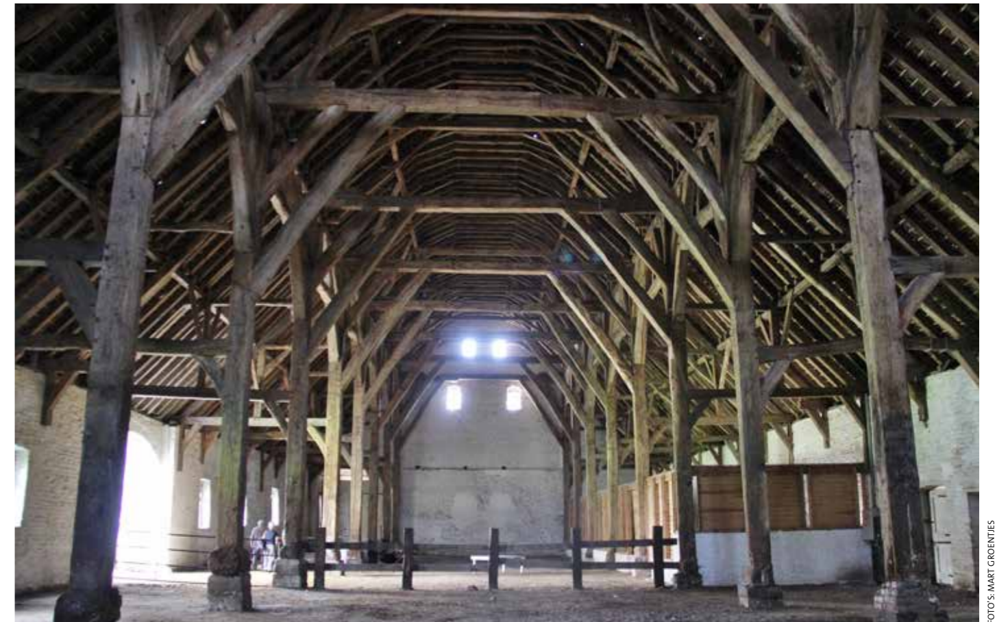
Interieur van de abdijsschuur Ter Doest uit ca. 1275. Oerprincipe en voorloper van de dekbalkenconstructie.
