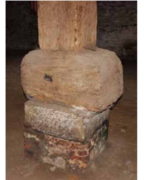
Staanders steunen op flinke, dubbele poeren.
