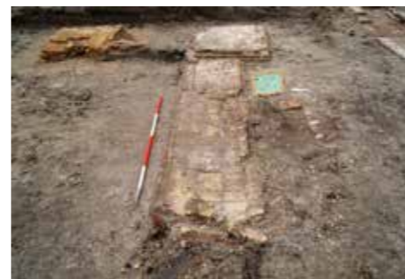
Op de voorgrond de rechthoekige bakstenen fundering van de oudste schoorsteen van de boerderij. Daarachter het fundament van een van de vierkantpalen, ook wel een poer genoemd. Linksachter de fundering van een schoorsteen die rond 1850 is gebouwd.
