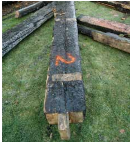
Een van de vierkantpalen van de stolp na de brand.
