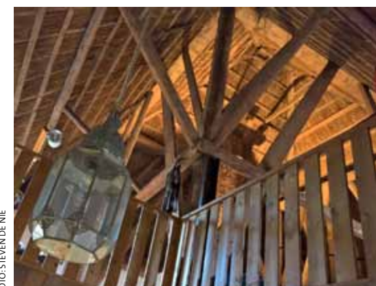
Zicht op de zolder met de vierkants- en dakconstructie.
