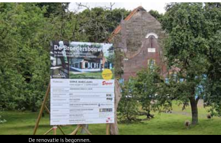
De renovatie is begonnen.
