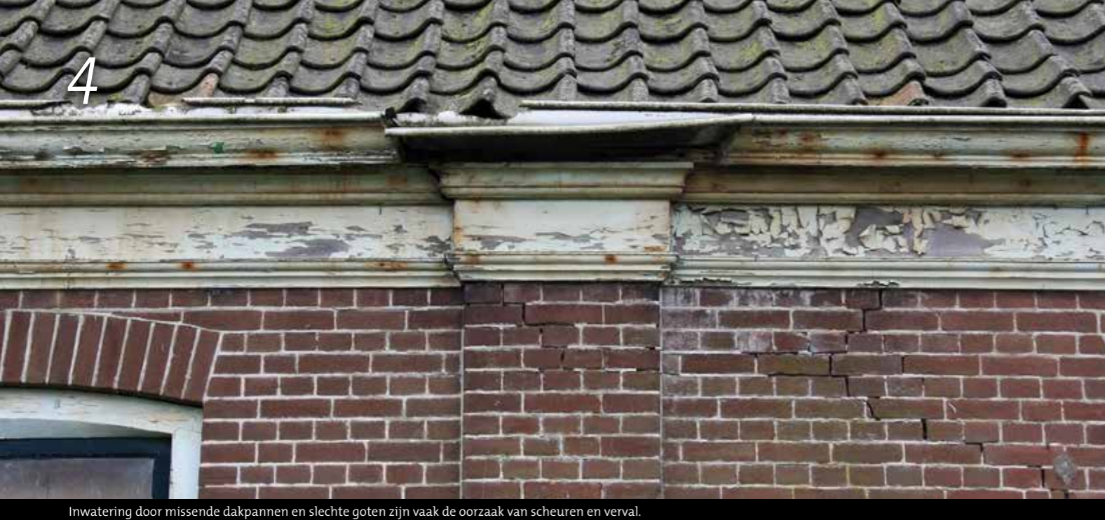
Inwatering door missende dakpannen en slechte goten zijn vaak de oorzaak van scheuren en verval.
