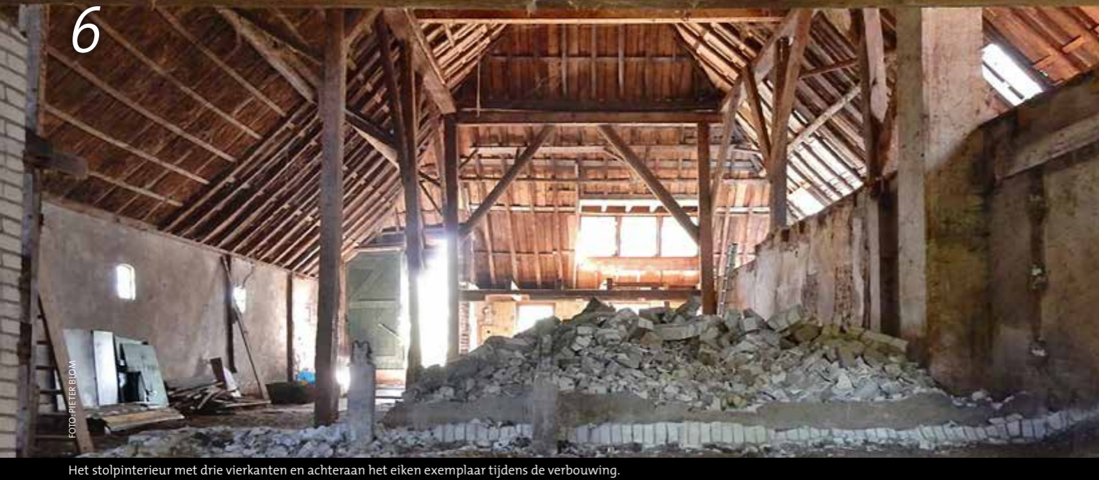
Het stolpinterieur met drie vierkanten en achteraan het eiken exemplaar tijdens de verbouwing.
