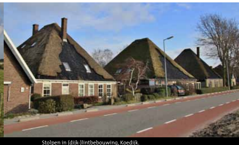
Stolpen in (dijk-)lintbebouwing, Koedijk.
