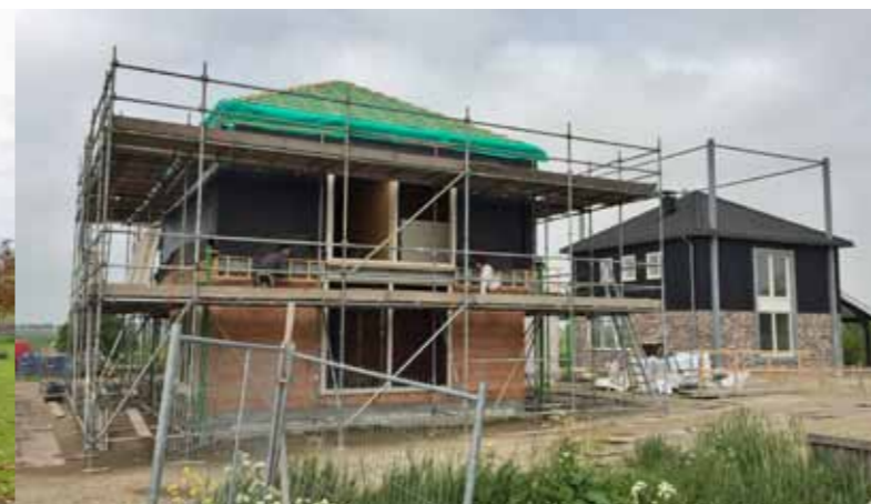
Schagerbrug. Nieuwe kapbergen. Ook hier een kruising met een vijzelberg.
