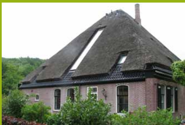
Dakraam-oplossing met verticale stroom.
