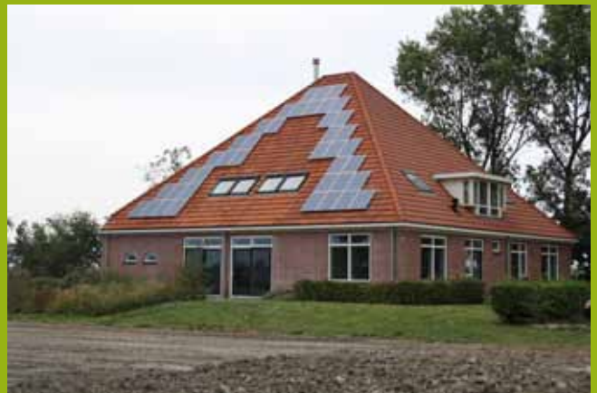
Aantasting van stolpdaken door zonnecollectoren.
