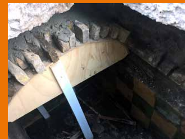
De regenwaterkelder tijdens de restauratie. Door middel van een houten mal kon het tongewelf opnieuw worden gemetseld. Rechtsonder zijn de groene en gele plavuizen tegen de binnenzijde van de kelderwand zichtbaar.
