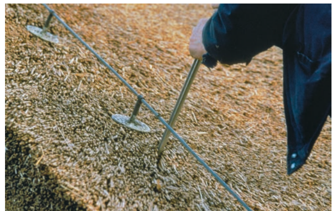
Een rietdekker legt bliksembeveiliging op het dak aan
