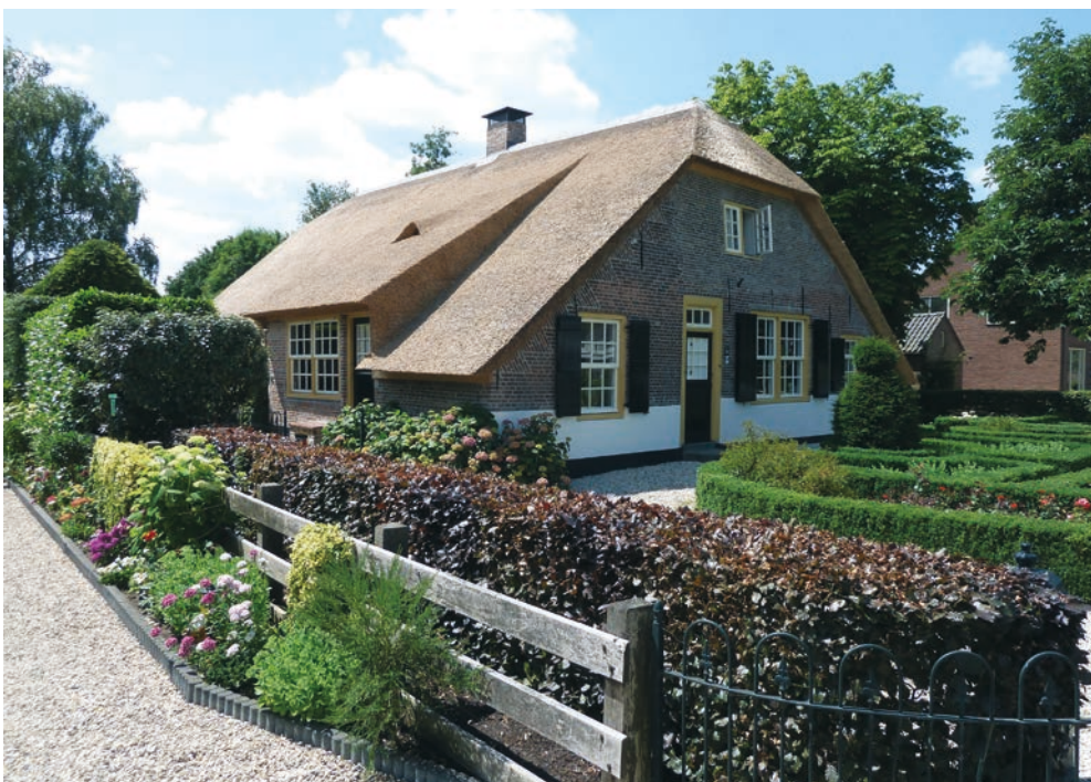
Een boerderij uit de achttiende eeuw tijdens en na een brand, en in herstelde staat. Deze brand was als schoorsteenbrand begonnen
